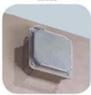
Kolay elektrik bağlantısı için dıştan elektrik bağlantı kutusu.
